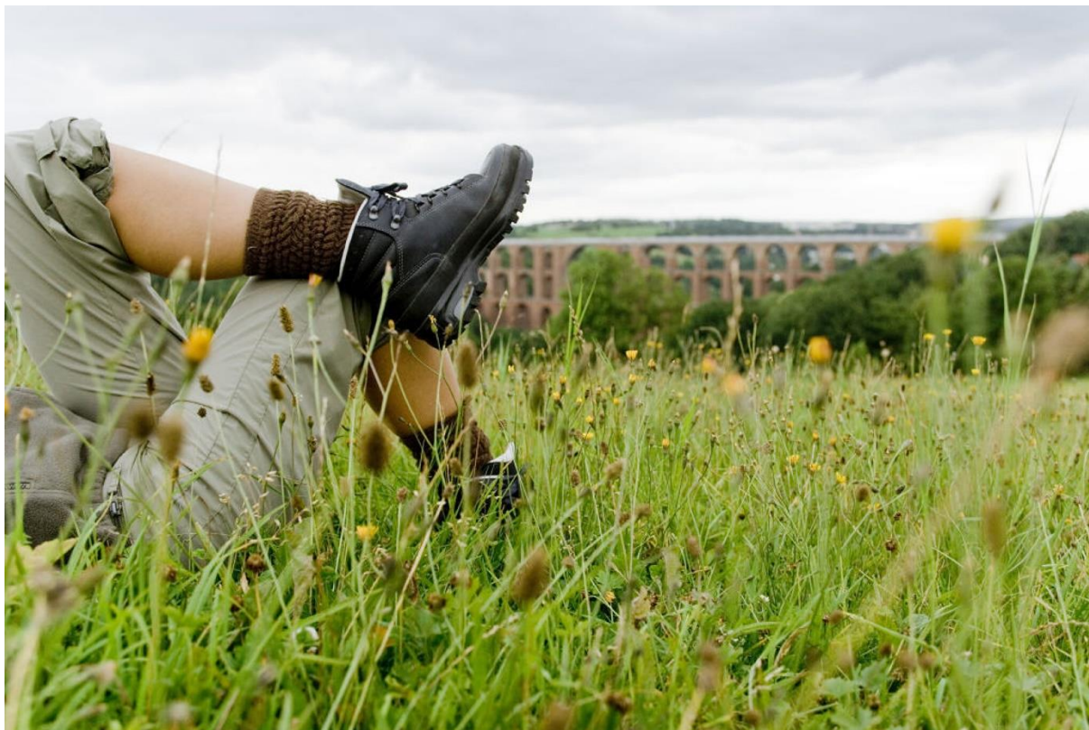
Der Blick auf die größte Ziegelsteinbrücke der Welt – die Göltzschtalbrücke. © René Gaens
